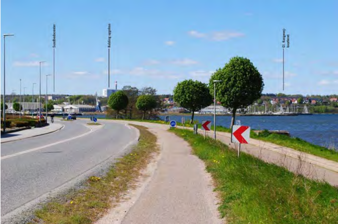
Figur 6-16 Eksisterende forhold set fra Skamlingvejen ved stuedfletning. Visualiseringspunkt nr. 3 (Figur 6-3).
