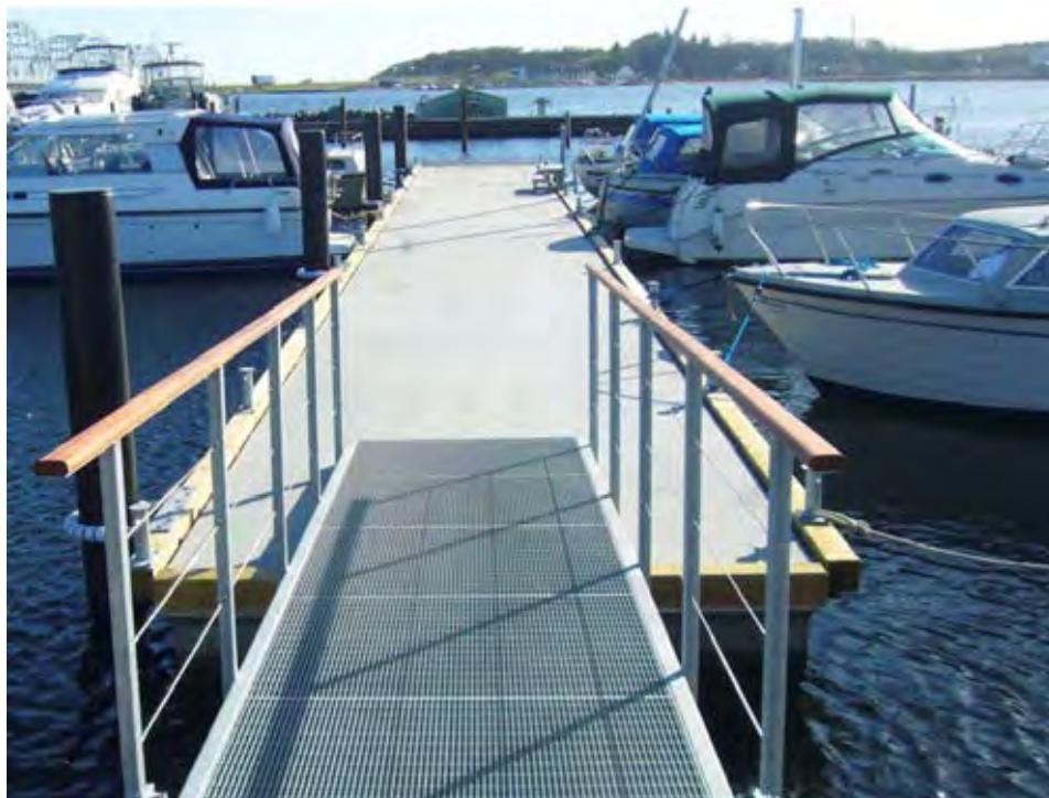
Figur 3-18: Eksempel på flydebro og landgangsbro
