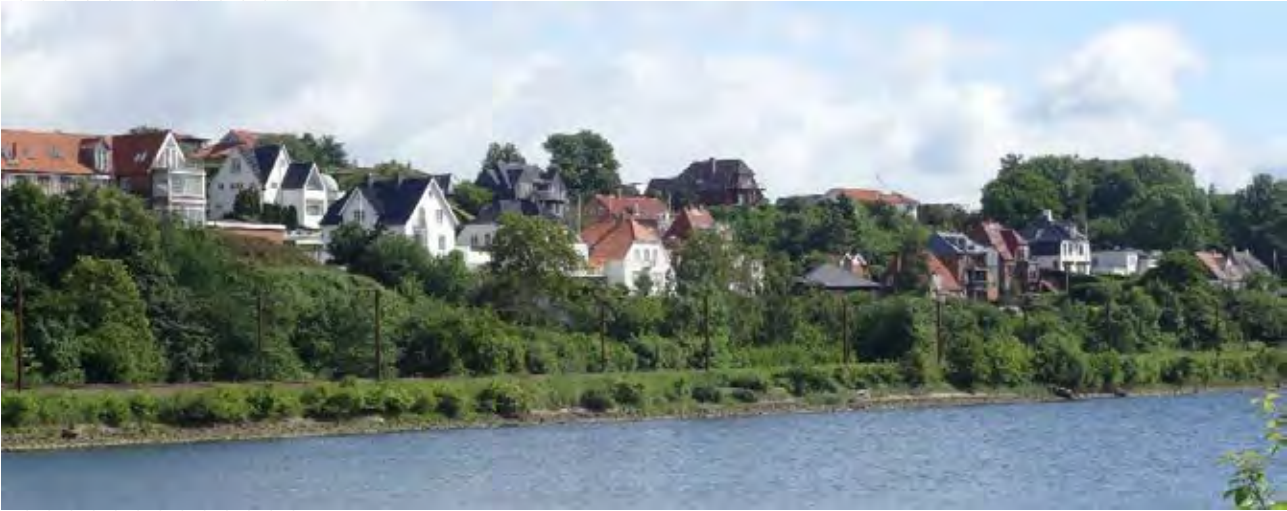
Figur 6-9 Langs hele nordkysten ligger ejendomme med tydelig relation til kysten. Her ses boligerne langs med Strandvejen.
